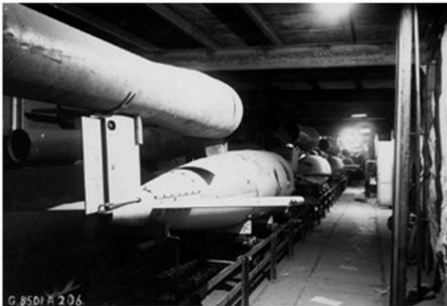
Figura 34. En Mittelwerk se ensamblaban tanto las V-1 como las V-2. En la fotografía, túnel transversal conteniendo bombas volantes V-1.
